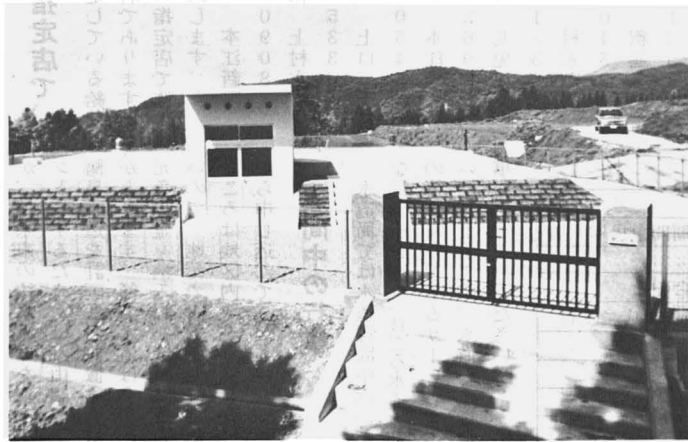
▲完成した石垣配水池
