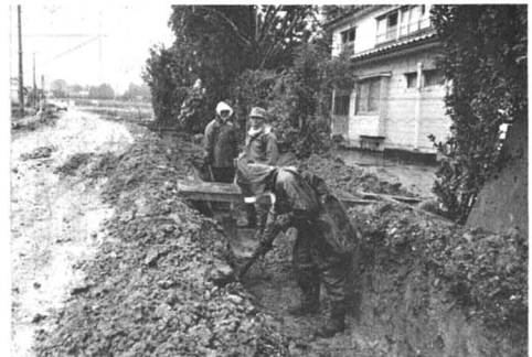
◀石垣地内の舗装工事現場
