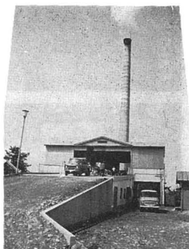
▼ ごみ焼却場が完成 (39年)
