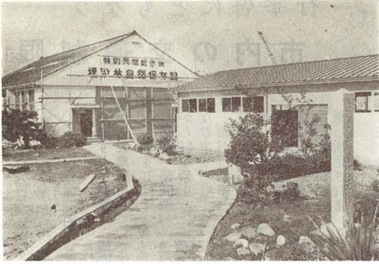
写真 = 改装中の埋没林博物館
