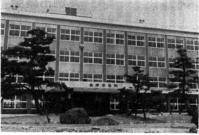
市庁舎概要 所在地=魚津市釈迦堂113番地 建築概要=鉄筋コンクリート造 4階建1部塔屋延6.650平方㍍
