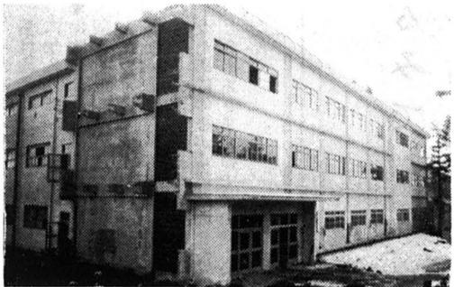
西部中学校の増改築は、継続工事として鉄筋コンクリート3階建の校舎を昭和36年からすすめてきました。
