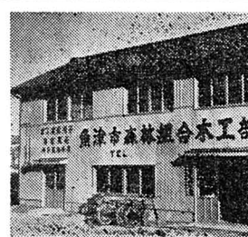
(写真は建設された森林組合木工所)
