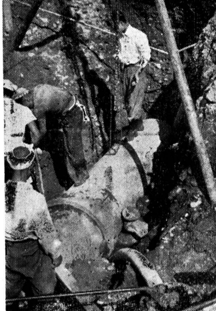
(写真は神明町附近の下水道管布設作業)
