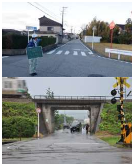
①R3点検 区画線引き直し
