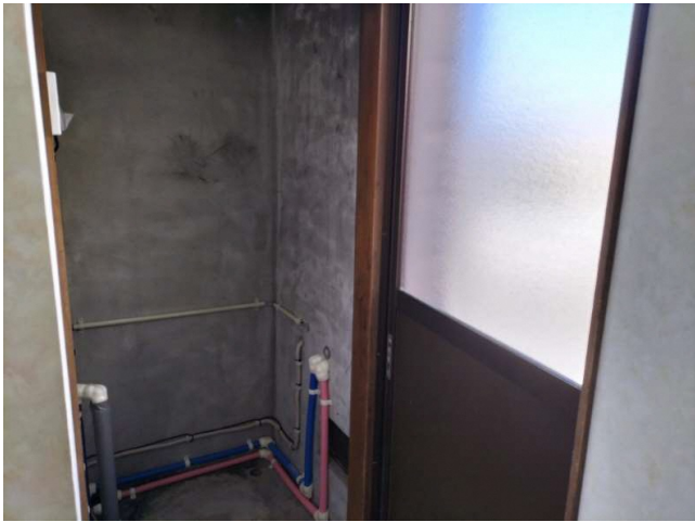
勝手口・物置(元ボイラー室)
