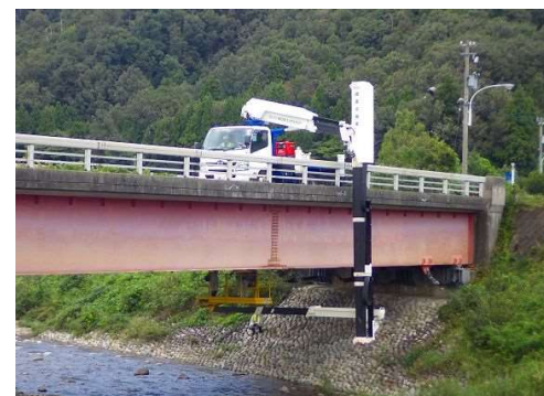
(橋梁下面の点検状況)
