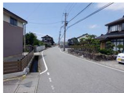
③道幅狭く、水路も沿っている
