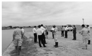
○経田漁港浚渫工事
