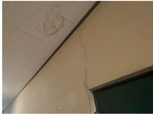
1階天井の水漏れと内壁のひび割れ
