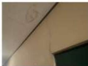
天井の水濡れと内壁のひび割れ
