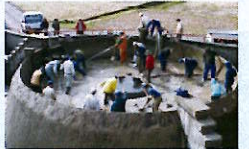
(排砂作業の様子)
