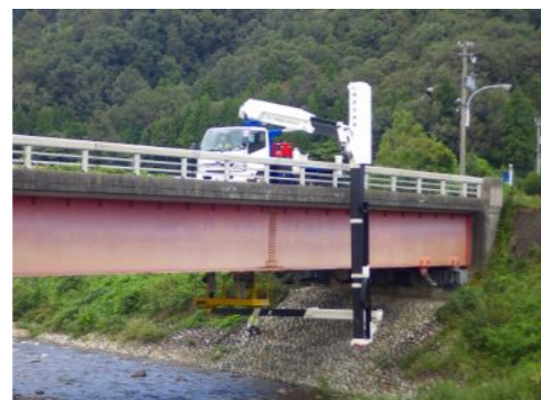
(橋梁下面の点検状況)
