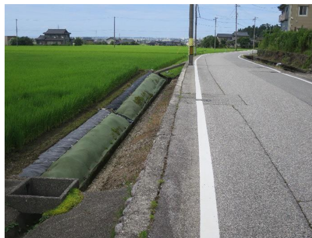
⑤道路の両側に幅1mほどの用水と高さ1mほどの溝 道幅もそれほど広くない。どちらにも柵がない。
