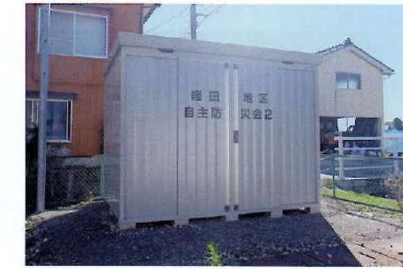
▲防災資器材を格納しています
