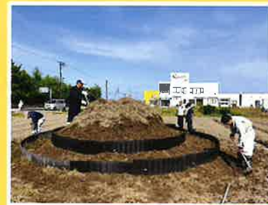
三段花壇の基礎工事
