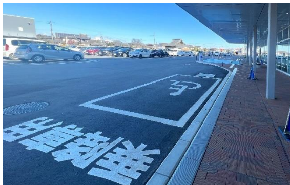
入口付近に設置した屋根付きの乗降場 (深谷市役所)
