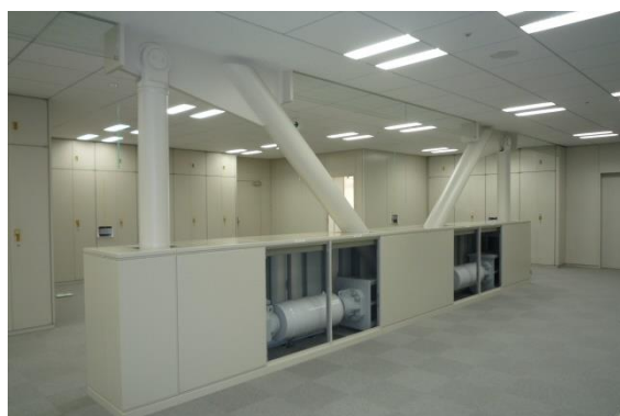
制振装置（出典：東京都HP） 壁の内部など、建物内部に設置し、地震のエネルギーを吸収して揺れを軽減する装置。
