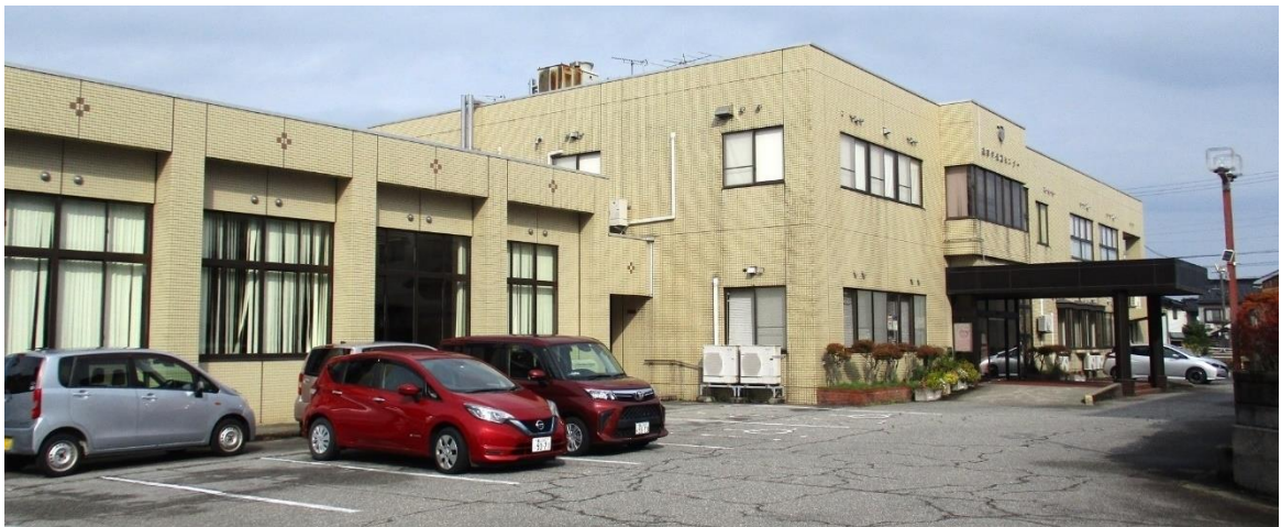
健康センター（昭和60年竣工・平成8年増築）
