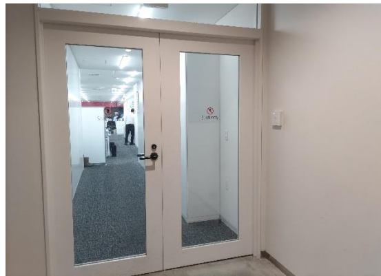
電気錠による区画（旭市役所）
