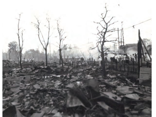
▲翌日の焼け跡（現在の新金屋付近）
