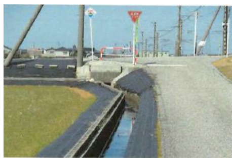
⑤道幅が狭く、危険
