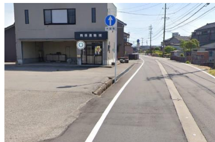
③側溝の蓋が突然なくなる
