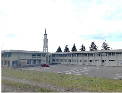
本館棟・レッスン棟
