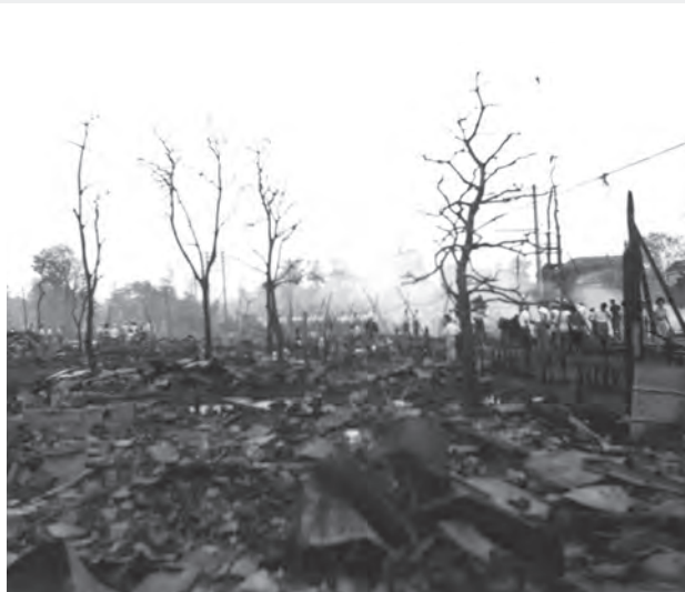
▲翌日の焼け跡（現在の新金屋付近）
