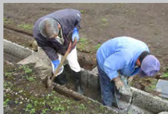
▲水路の簡易な補修
