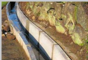
▲老朽化した水路の更新
